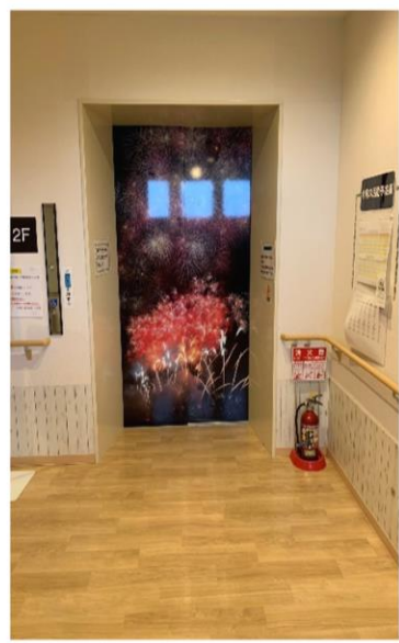
二階のエレベーター
